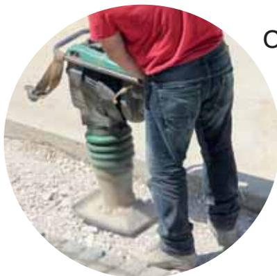
Oft fährt F\_\_orian Pohl auch zu Kunden. Dort arbeitet er meistens d\_\_außen. Er b\_\_aucht für die Arbeit bei den Kunden unterschiedliche Geräte, zum Beispiel verdichtet er Böden mit einem **Rüttler**. So wird der Boden g\_\_att und sein Kollege kann P\_\_atten legen.
